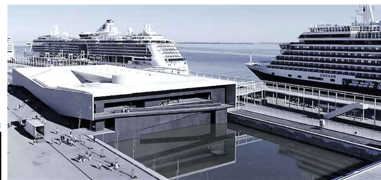
Terminal de Cruzeiros de Lisboa Arq. Carrilho da Graça
